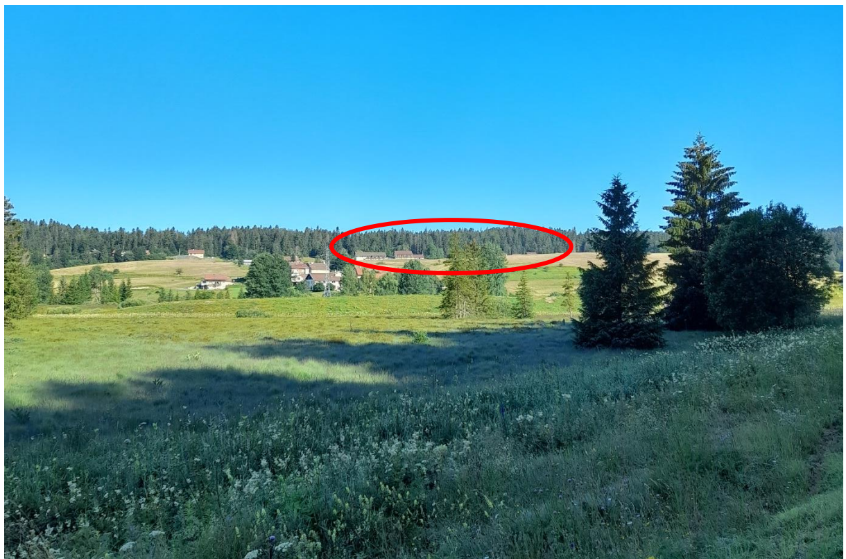
Prise de vue depuis la RD 232 sur le site de la maison de Trémontagne en dernier plan (par PNRHJ)
