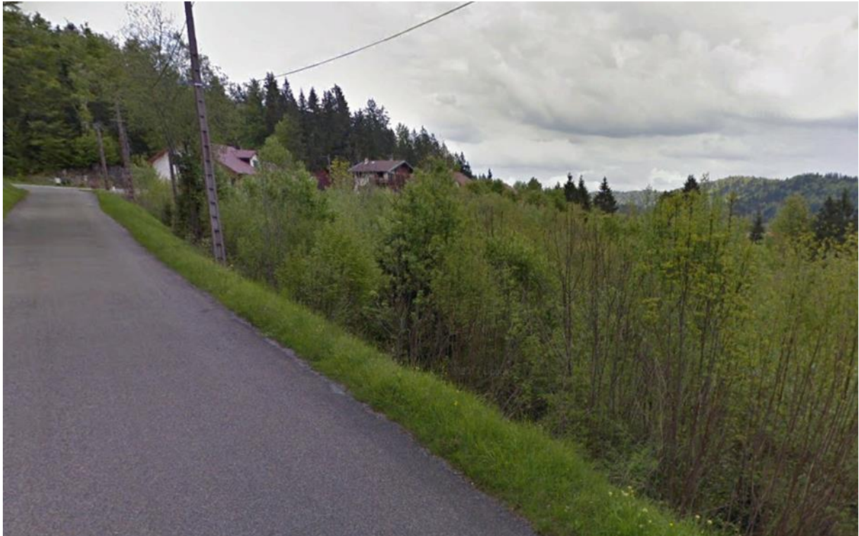
Prise de vue Google Earth, depuis la RD 28, en direction de Saint-Maurice-Crillat, avant la bifurcation menant à l'UTNL
