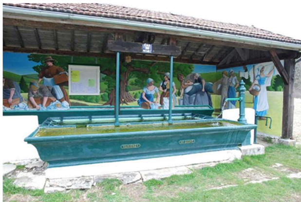
Exemple de fontaine-lavoir au hameau de la Boissière (la Chaux-du-Dombief)
