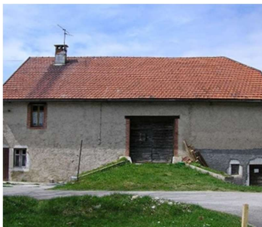
Pont de grange remblayé (Source : PNRHJ)
