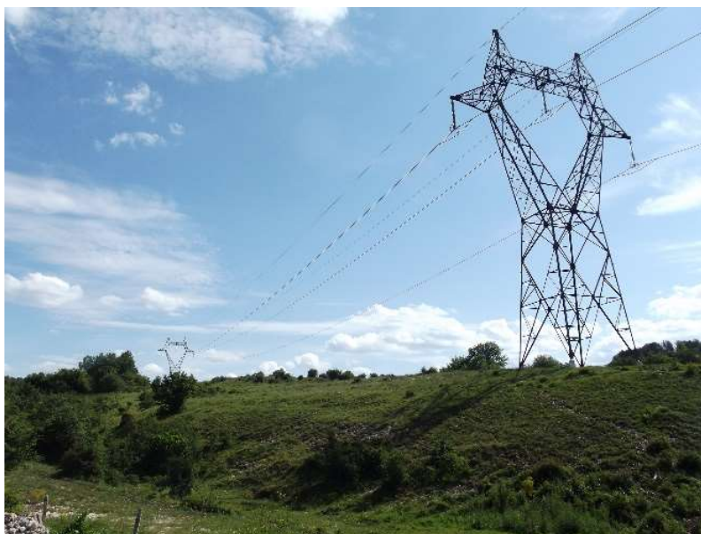
Passage d'une ligne à haute tension dans la partie Ouest de la commune de Fort-du-Plasne
