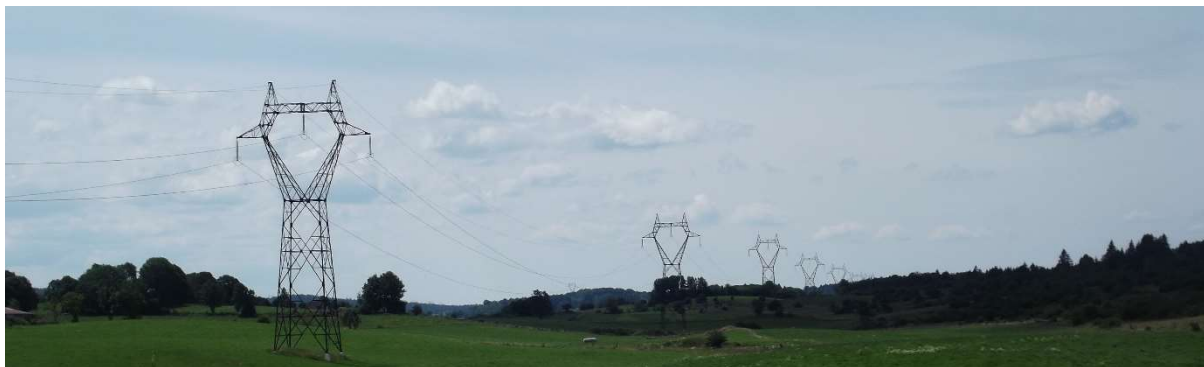
Passage de la ligne à haute-tension derrière la commune de Saint-Pierre
