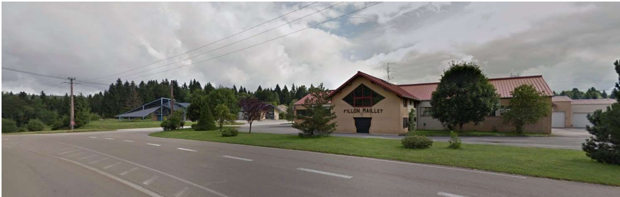
Vue sur les Fourneys (Le Clos dernier) depuis la RD 678 (Source : PNRHJ)
