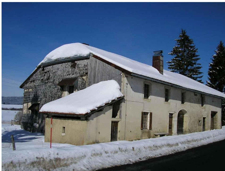
Appentis accolé à la façade d'une ferme du Grandvaux
