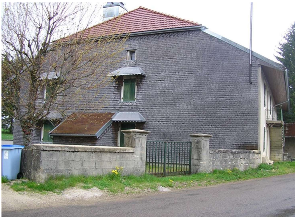
Exemple de demi-croûpe sur une façade de tavaillons à Fort-du-Plasne
